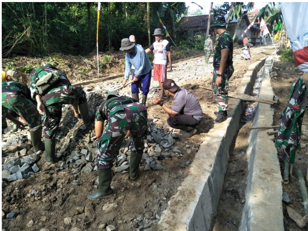
Gambar 1 Pelaksanaan Pembangunan Jalan Infrastruktur Desa Cipaunng
