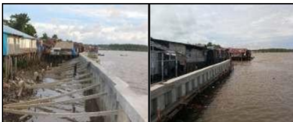
Gambar 4.6 Pemasangan Talut di Kampung Yufri dan Yaun Distrik Joerat
